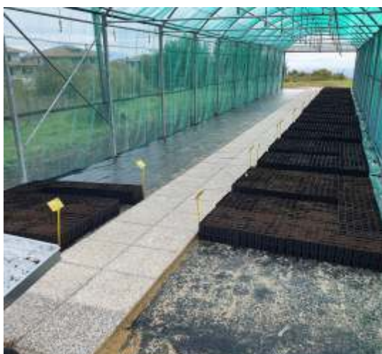
Pavimentazione di una serra destinata alla coltivazione di piante in contenitore - foto Luca Scarnati ARSIAL
