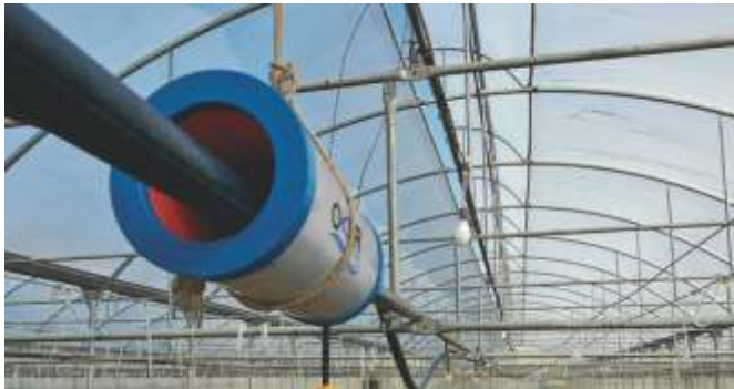
Attrezzatura per il trattamento fisico dell'acqua del vivaio foto Overtis S.r.l.
