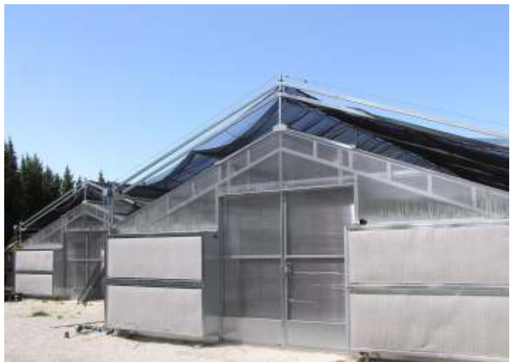
Serre in policarbonato con sistema di ventilazione forzata foto Moreno Moraldi
